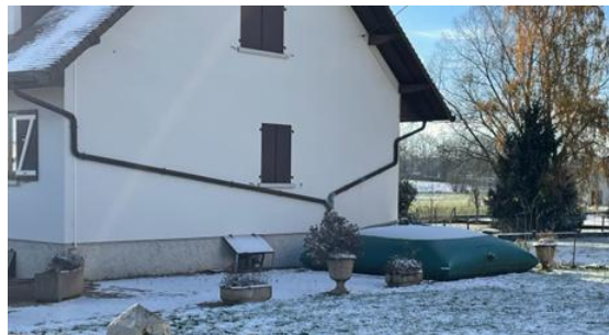
CITERNE RÉCUPÉRATION EAU DE PLUIE
