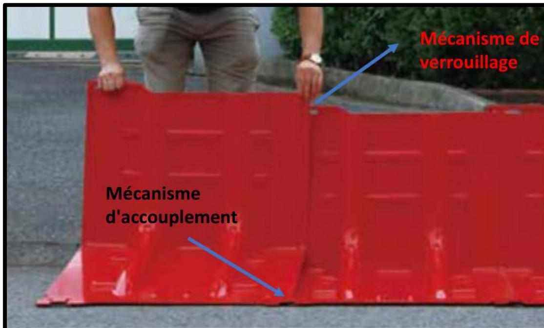
INSTALLER LA BARRIÈRE BARM2022 DE GAUCHE À DROITE, INSÉRER D'ABORD LE MÉCANISME DE COUPLAGE. SI VOUS VOULEZ AJUSTER L'ANGLE, DÉPLACEZ LÉGÈREMENT LE SYSTÈME DE VERROUILLAGE D'ENVIRON  $\pm 3^\circ$  DEGRÉS COMME ILLUSTRÉ CI-DESSOUS.
